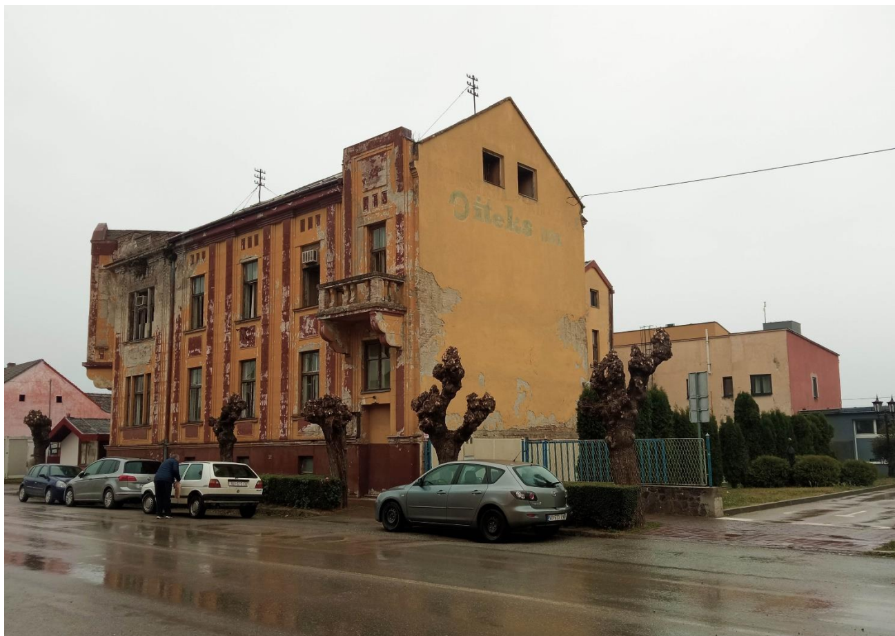
Fotografija 21. Zgrada Kotarskog suda u Iloku
